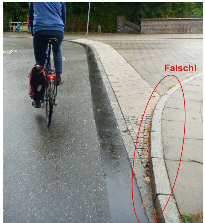
Abbildung 23: Falsche Ausbildung einer Gehwegüberfahrt, ebenfalls Hamburg. Der Bordstein folgt der einmündenden Straße (Uferstraße/Von-Essen-Straße).
