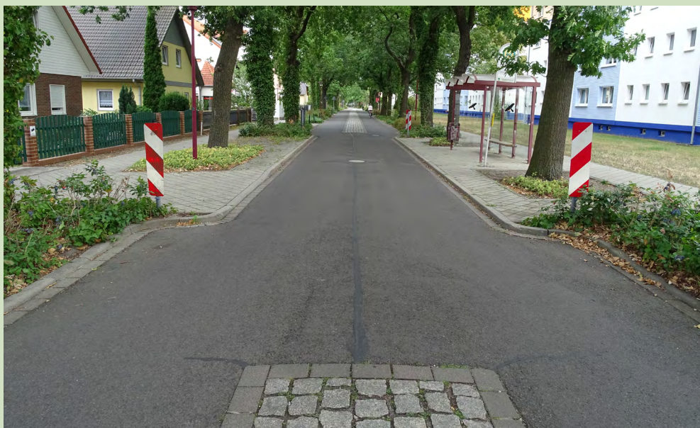
Abbildung 40: Haltestellenkap im Bereich der Bushaltestelle. Der gepflasterte Mittelstreifen ist hier unterbrochen (Ernst-Thälmann-Straße).
