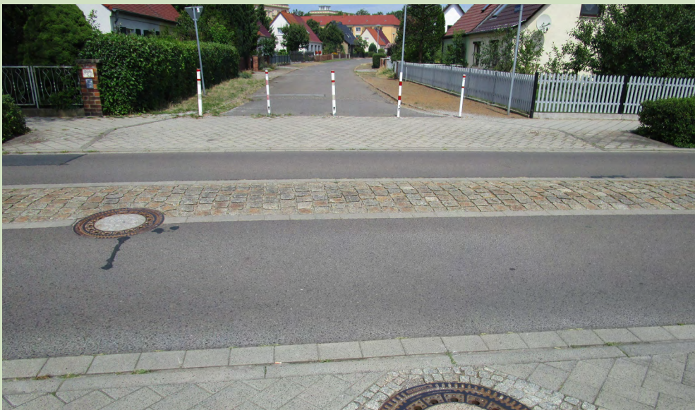
Abbildung 41: Die einmündende Straße ist durch Poller abgetrennt (Hörlitzer Straße/Nelkenweg).
