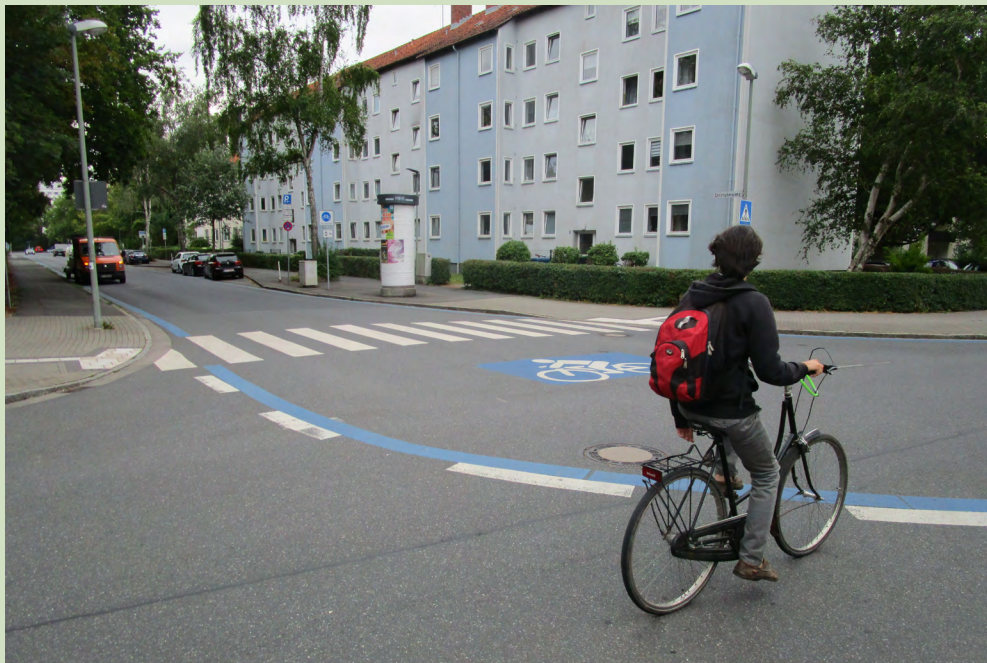
Abbildung 15: Blauer Breitstrich im Bereich des eRadschnellweges, der auch gleichzeitig die Vorfahrtstraße verdeutlicht (Christophorusweg/Goßlerstraße).
