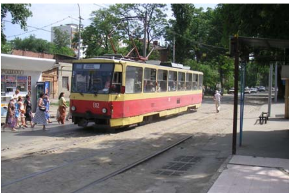
Abbildung 3: Straßen- und Gleiszustand in der Maxim-Gorkogo-Straße
