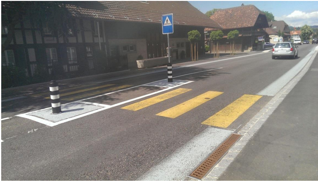
Abbildung 9: mangelnde Leitelemente in der Käsestraße
