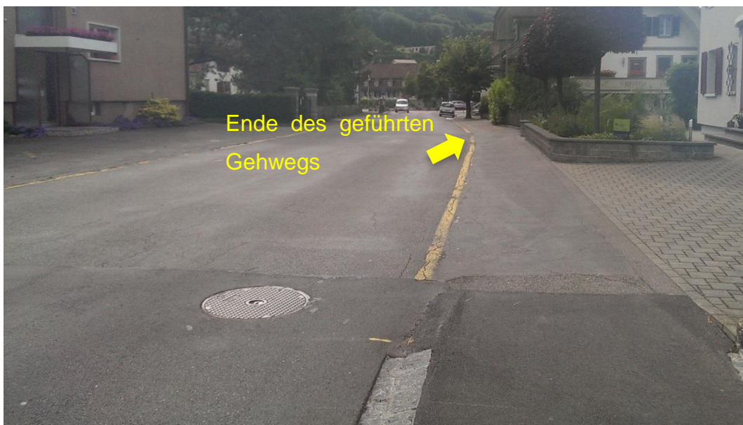
Abbildung 10: Fußgängerführung in der Dorfstraße
