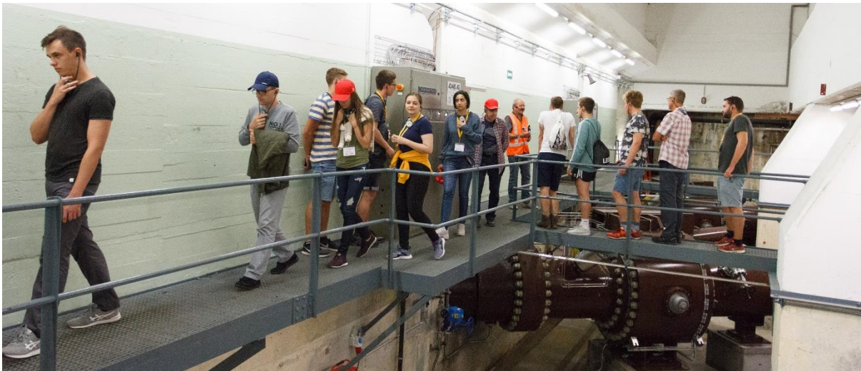
Abbildung 11: Die Workshop-Gruppe im inneren des Wasserkraftwerks, Foto: Benjamin Maibach
