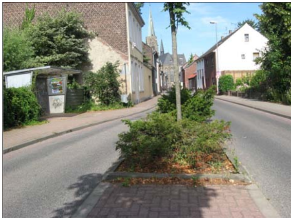
Sichtbehinderungen an empfohlener Überquerungsstelle durch Sträucher
